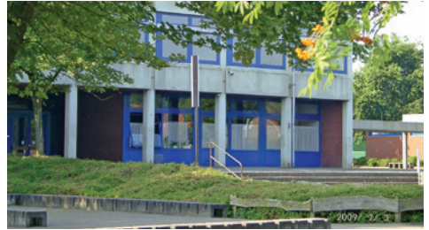
Errichtung des „Lernzentrums Horstmar“ am Drostenkämpchen in Horstmar
